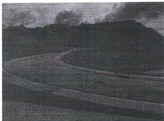
Foto 03- Vista da pista e dos taludes.
