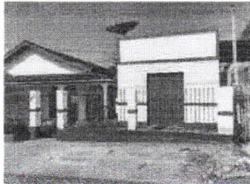
Foto 02 - Vista do muro e ponto comercial
