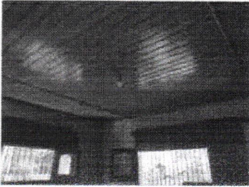
Foto 13 - Forro em madeira
