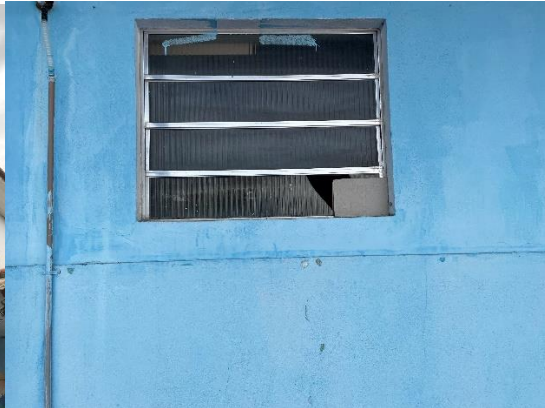
Figura 12 – Janela Danificada
