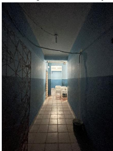
Figura 03 – Instalações aparentes
