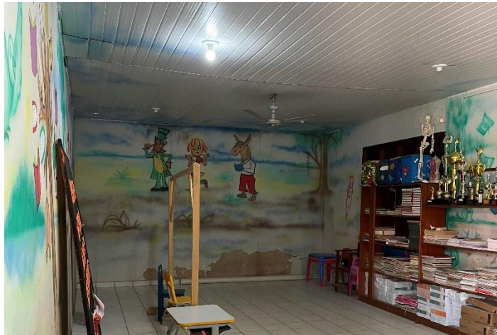
Figura 04 – Infiltração e Danificação do Forro
