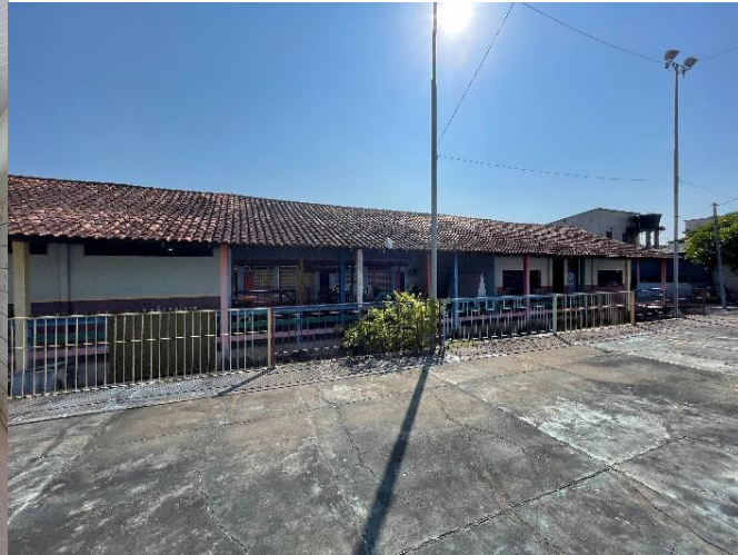
Figura 08: Bloco Administrativo e de Apoio
