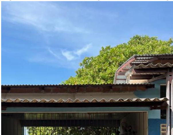
Figura 11: Falta de Encalçamento
