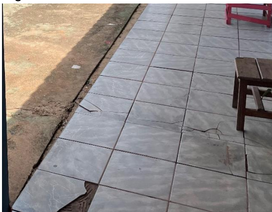
Figura 07: Piso Danificado
