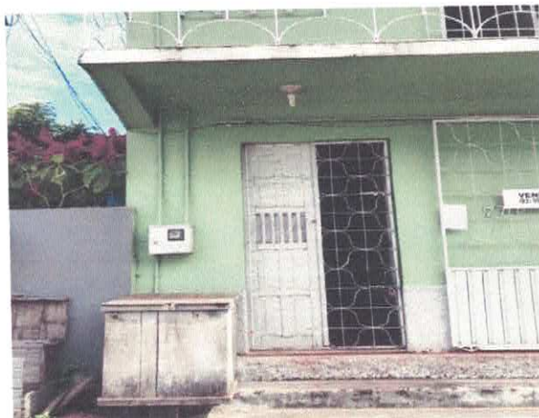
Foto 02 – Acesso segundo pavimento
