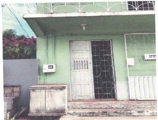
Foto 02 – Acesso segundo pavimento
