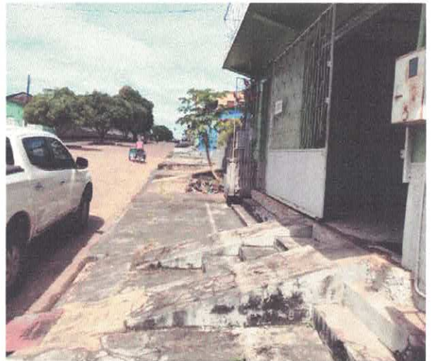
Foto 20 – Calçada e rampa de acesso
