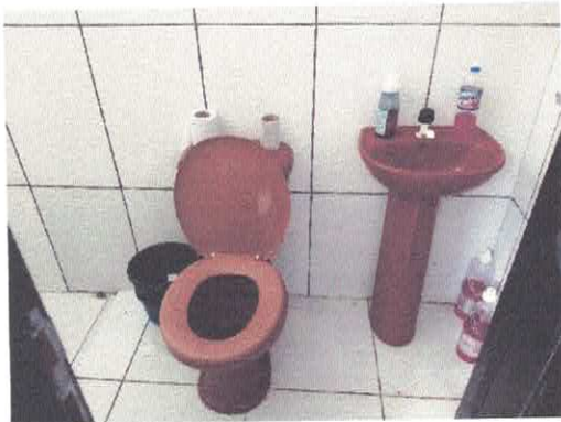
Foto 05 – Vista de vaso e lavatório no banheiro.
