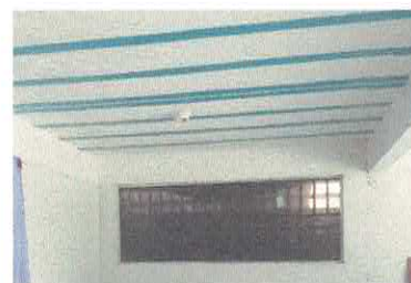
Fotos 24 e 25 – Falta de lâmpadas nas luminárias.
