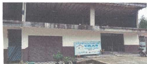
Foto 28 – Vista da fachada.
