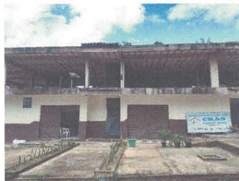
Foto 18 – Falta de paredes no piso superior.
