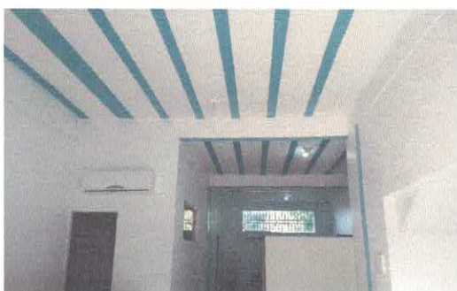
Foto 05. - Detalhe de Pilares, vigas e laje.
