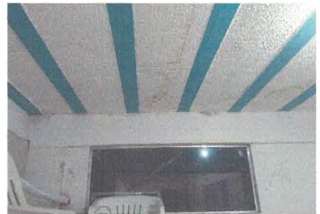
Foto 09– Parede e laje com infiltração.
