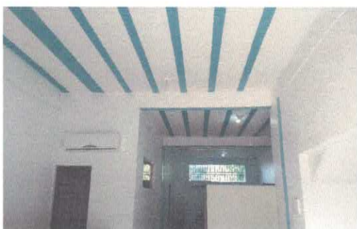
Foto 05. - Detalhe de Pilares, vigas e laje.
