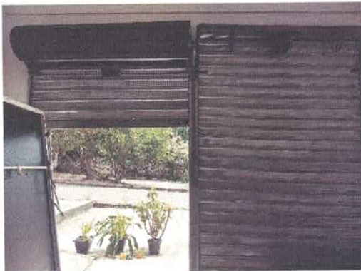
Foto 07 – Porta metálica de enrolar.
