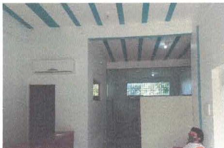
Foto 23 – Central de ar de sala, sem tomada para ligar.
