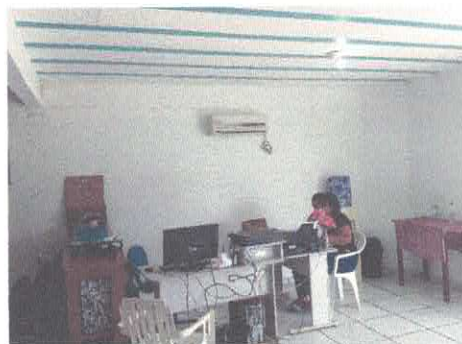
Foto 22 – Central de ar da recepção, sem tomada para ligar.
