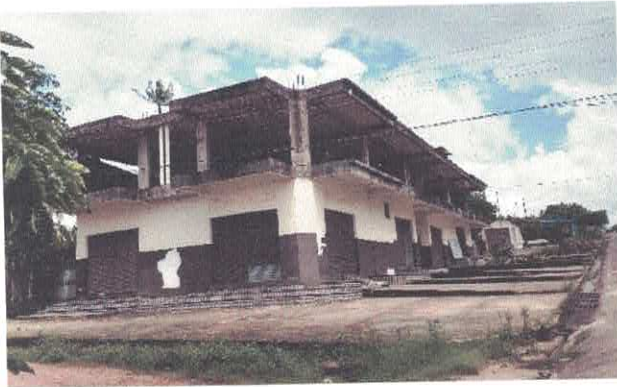
Foto 01- Vista geral de esquina.
