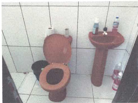
Foto 14 – Vaso e lavatório.
