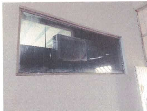
Foto 08 – Janela fixa, em vidro.
