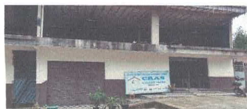
Foto 28 – Vista da fachada.
