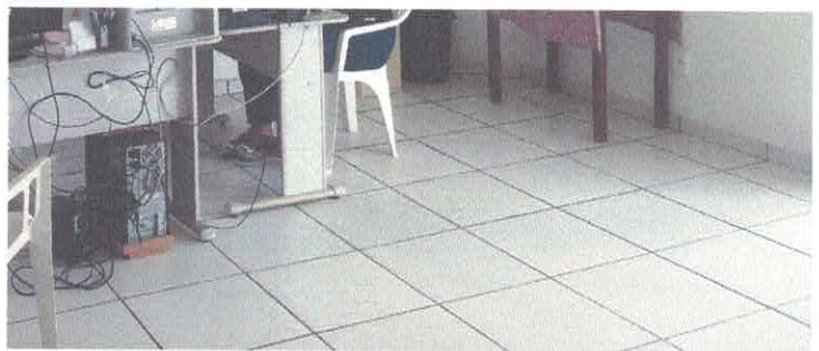
Foto 11 – Piso cerâmico na área de recepção.
