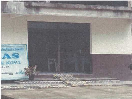
Foto 35 – Porta principal, metálica de enrolar.
