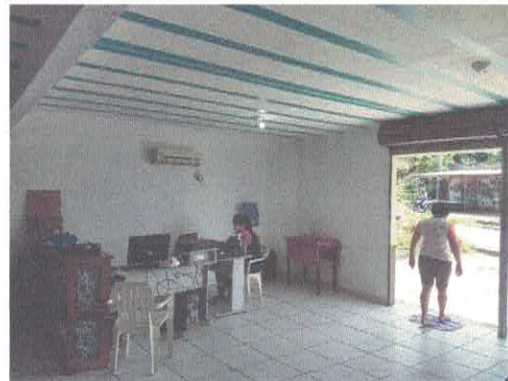
Foto 36 – Porta principal e ao fundo a central de ar.
