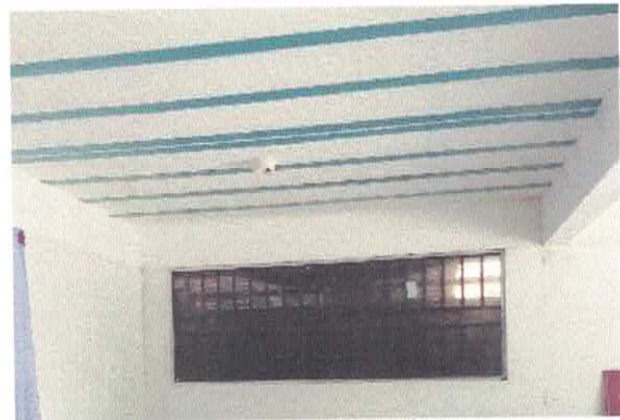
Foto 04 – Vista de janela.
