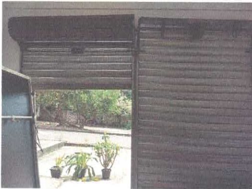
Foto 37 – Porta metálica de enrolar.
