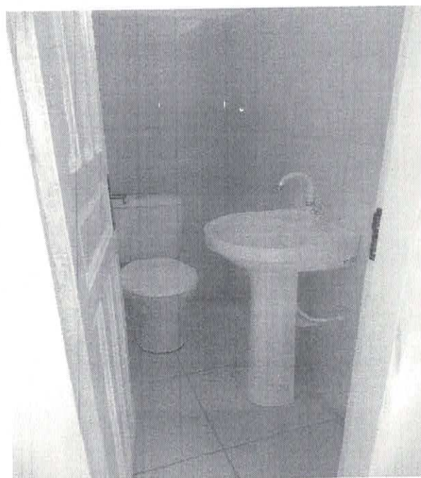
Foto 03- Vista interna do banheiro.
